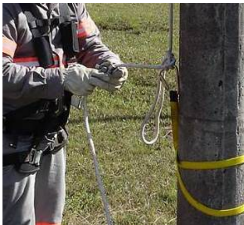
Figura 39 – Instalação do trava-quedas
