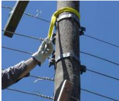
Figura 16 – Ancoragem com fita e mosquetão no poste
