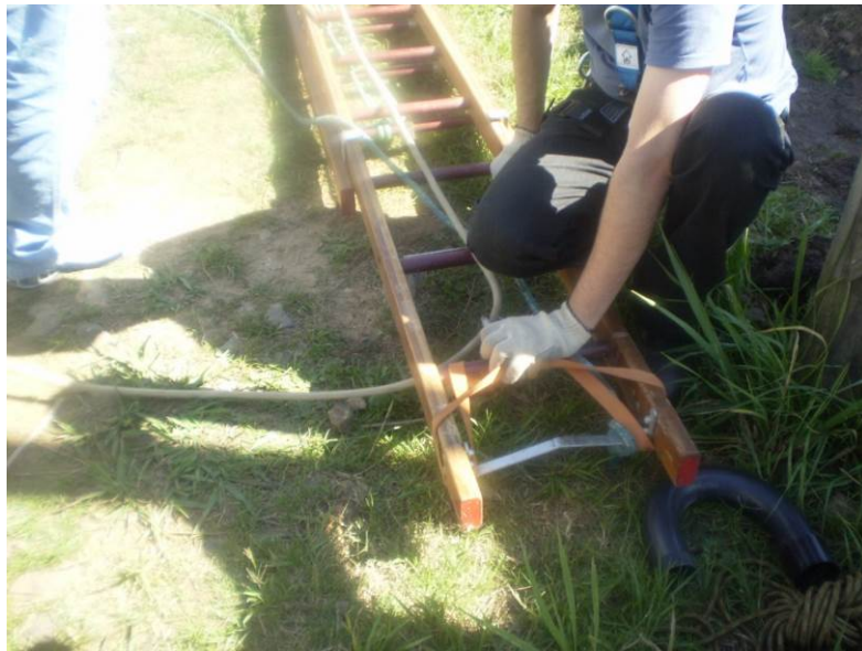
Figura 13 – Instalação da linha de vida
