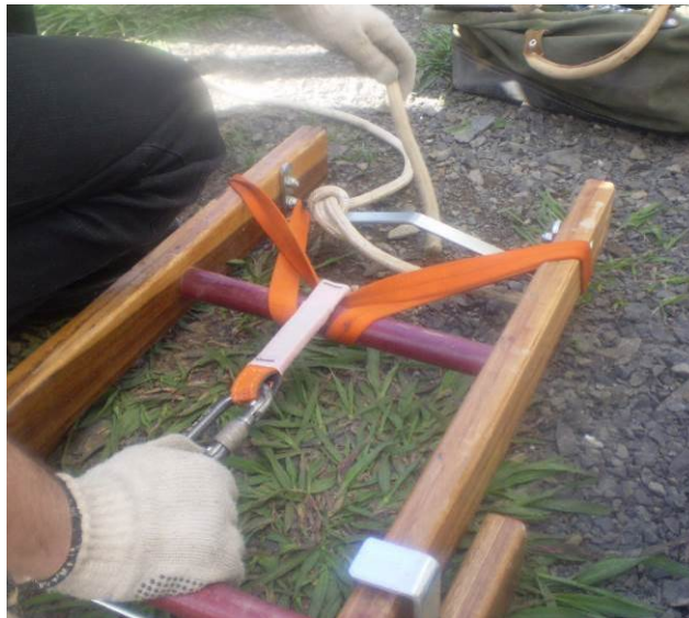
Figura 12 – Instalação do ponto de ancoragem
