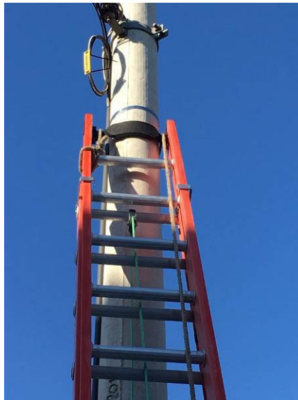
Figura 23 – Posicionamento da escada
