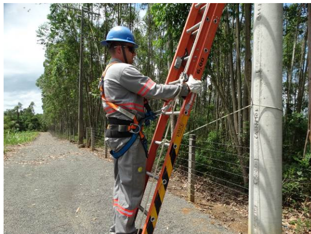
Figura 37 – Subida na escada
