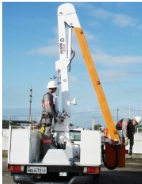
Figura 43 – Posição do cesto aéreo para retirada de acidentado
