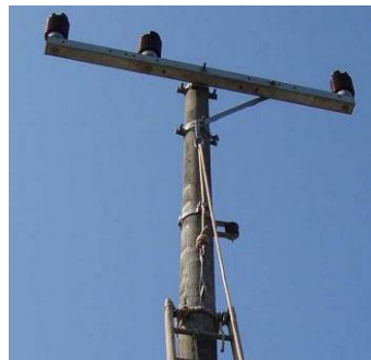
Figura 17 – Ancoragem na ferragem do poste
