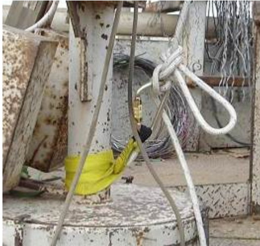
Figura 11 – Ponto de ancoragem
