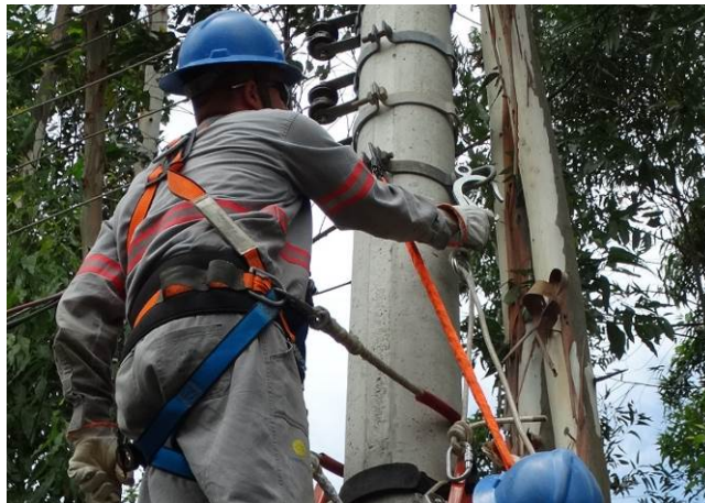
Figura 48 – Fixação do ponto de ancoragem
