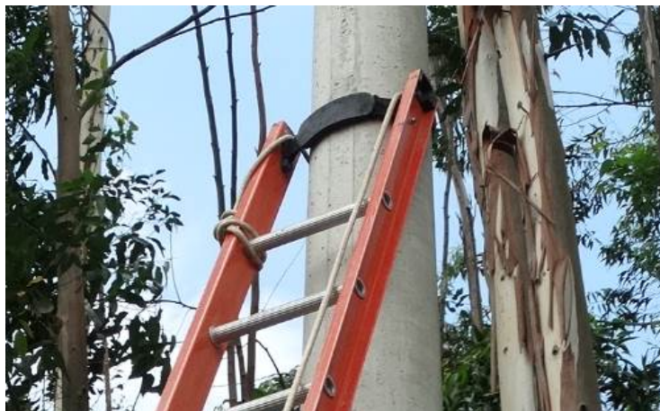
Figura 22 – Posicionamento da escada
